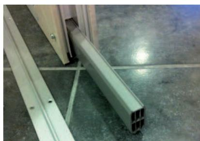
Poi inserire sotto ad essa il profilo fornito nel kit il quale permette che l'anta sia centrata con il binario a pavimento.
