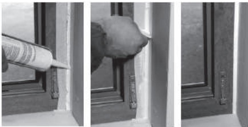
*Le prime tre figure in alto raffigurano le corrette operazioni di applicazione del sigillante acrilico sulla parte interna del giunto ed il livellamento del materiale.*
