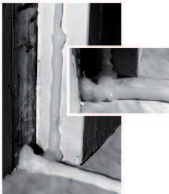
*Figura a sinistra: sezione della spalletta con il cordolo e siliconatura sull'aletta di battuta del vano finestra.*
