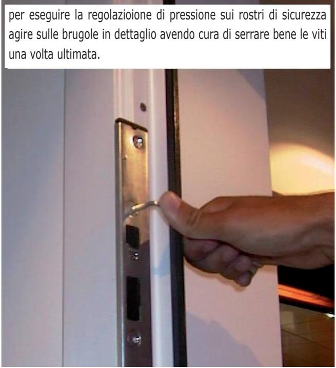
per eseguire la regolazione di pressione sui rostri di sicurezza agire sulle brugole in dettaglio avendo cura di serrare bene le viti una volta ultimata.
