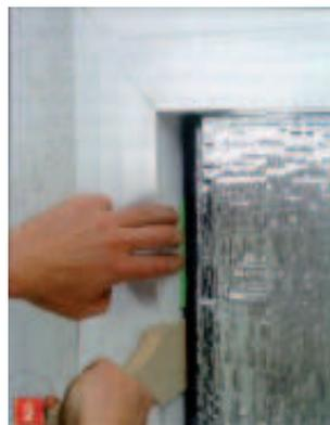
Le figure a lato rappresentano le tre fasi principali di spessoramento di un serramento.
