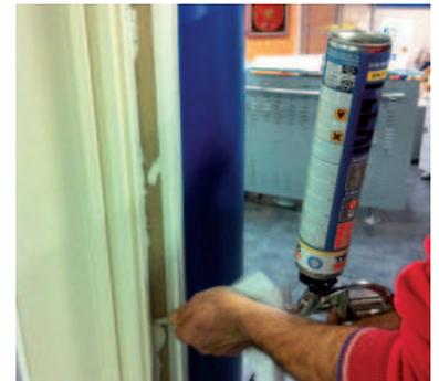
Ultimare la posa dello scorrevole posizionando la copertina nodo centrale dell'anta fissa, per aumentare la tenuta eseguire dei cordoli di silicone facendo attenzione che non fuoriesca; posizionare il gommino di tenuta ed eseguire la schiumatura tra telaio e muratura; infine applicare le cornici coprifilo.
