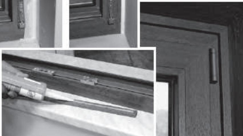
Nel caso in cui sia stato corretto un difetto di piombo della spalletta, è necessario controllare tutto il perimetro esterno di contatto tra la spalletta ed il telaio, per verificare la funzionalità del cordolo di silicone applicato in precedenza durante la posa del telaio. L'eventuale fuga esistente dovrà essere sigillata ulteriormente per ricoprire le discontinuità.
