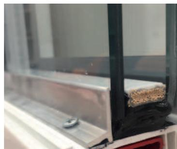
Massima attenzione dovrà essere utilizzata nel fissaggio dei profili in alluminio a ridosso del vetro in quanto c'è la possibilità di rovinare il vetro stesso o i profili in pvc con il mandrino del trapano o scivolando con l'avvitatore. Per questo motivo si consiglia di utilizzare una protezione (come da foto) per evitare eventuali danneggiamenti.
