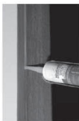
La figura raffigura l'operazione di sigillatura del giunto di dilatazione (operazione c).
