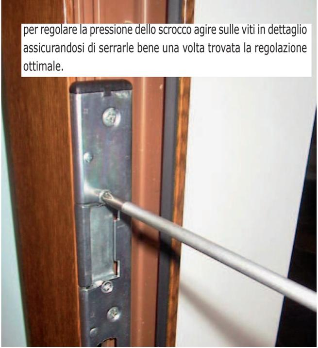
per regolare la pressione dello scrocco agire sulle viti in dettaglio assicurandosi di serrarle bene una volta trovata la regolazione ottimale.
