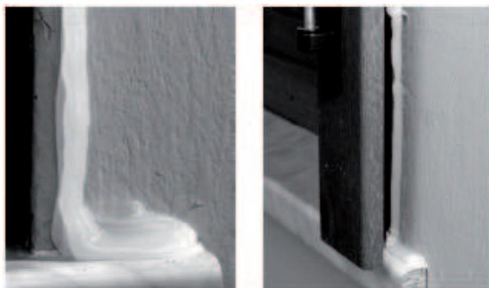
La sigillatura del vano murario deve essere effettuata posizionando il cordolo del silicone in corrispondenza della mezzerie del telaio della finestra secondo le modalità descritte nei paragrafi precedenti. Sulla parte esterna del vano finestra, in corrispondenza dei tre lati di battuta del telaio della persiana deve essere posizionato un cordolo di silicone per sigillare la battuta del telaio del monoblocco (vedi particolare su figura a lato).
