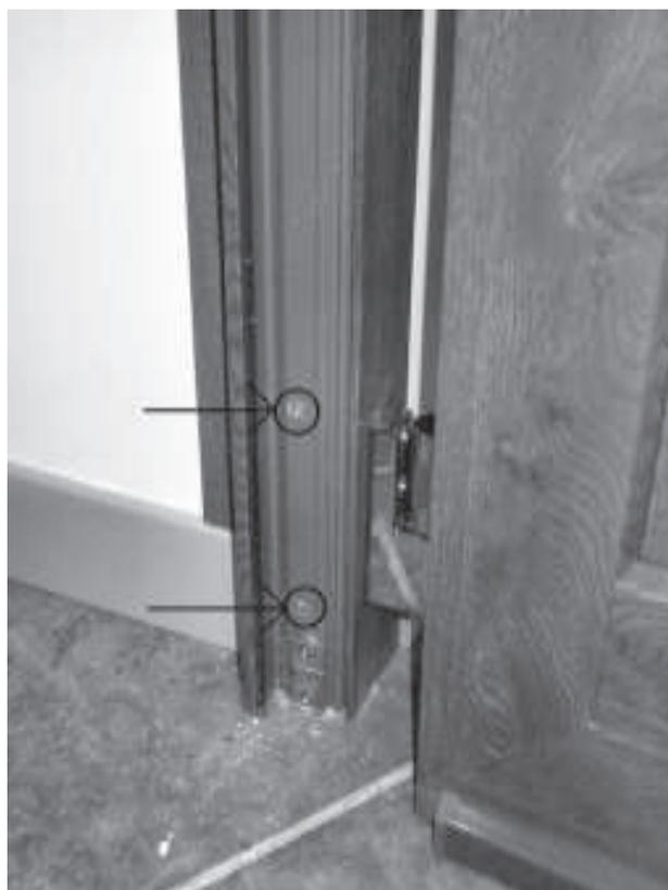
*Figura: particolare cerniera inferiore con doppia vite.*
