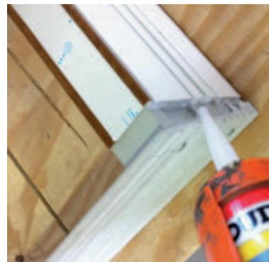
Prima di fissare la soglia ai montanti verticali del telaio è opportuno eseguire una buona sigillatura dei tappi in gomma in modo da evitare eventuali infiltrazioni, eseguire piccoli cordoli di silicone in modo che esso non fuoriesca con la pressione al momento del fissaggio.
