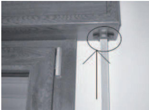
Alla posa dei cassonetti deve seguire sigillatura perimetrale interna, per assicurare un'ottimale tenuta all'aria. Il foro per la cinghia di azionamento deve essere eseguito a piombo con la scatola dell'avvolgibile per evitare l'usura della cinghia stessa, a causa di abrasioni laterali
