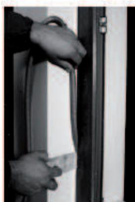
La figura raffigura l'operazione di inserimento del cordolo (operazione a).
