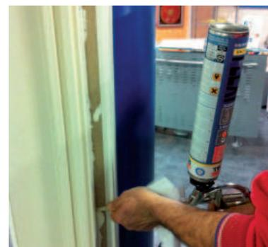
E' necessario, dopo aver controllato che il serramento entri agevolmente sul vano, eseguire un cordolo con materiali isolanti (resina chimica o sigillanti siliconici a reticolazione neutra) o con schiume isolanti, si deve riempire lo spazio tra telaio e muratura e sigillare attentamente la soglia inferiore nei punti evidenziati in rosso.
